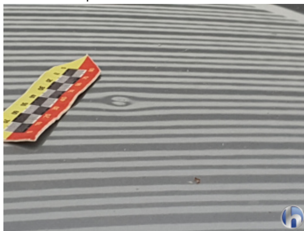
5. Dach 1 Delle - Sanft Instandsetzen
