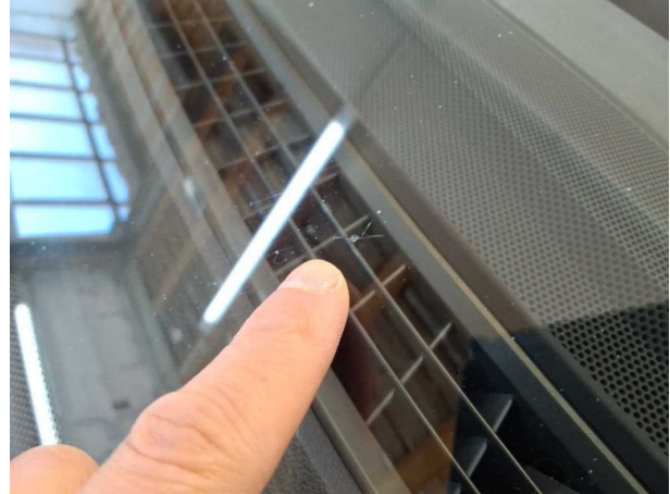
Beschädigung #8: Verglasung: Frontscheibe - Steinschlag - erneuern
