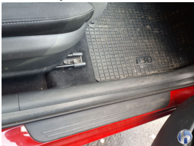
7. Verkleidung Verschmutzt - Reinigen
