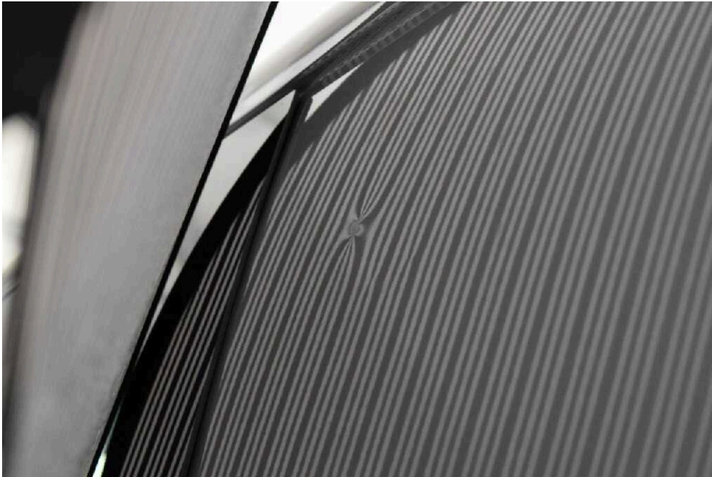
Bild 41 linke Seite Seitenwand links Kratzer/Dellen
