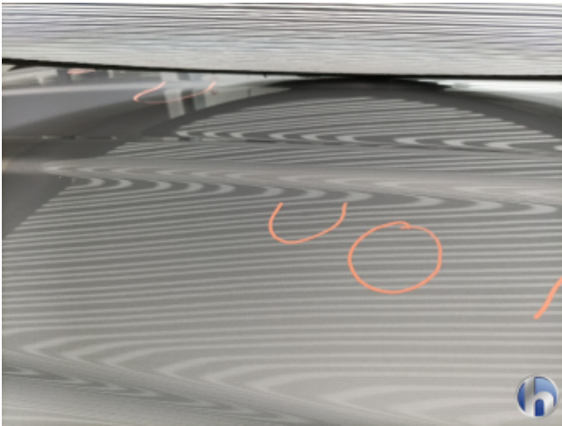
1. Dach Hagelschaden - Sanft Instandsetzen
