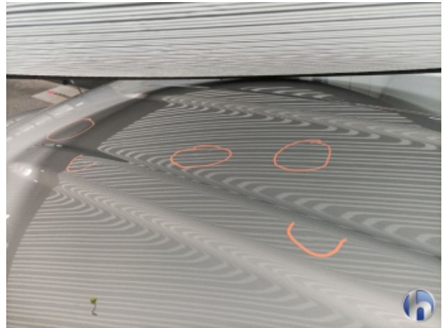
1. Dach Hagelschaden - Sanft Instandsetzen
