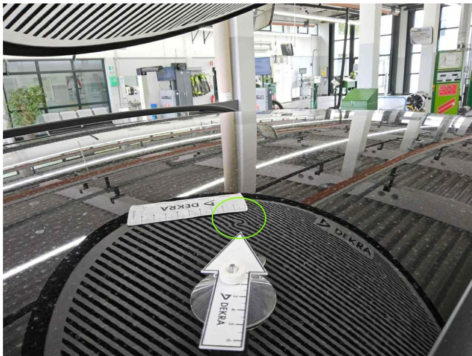
Bild 15 : Dach, mehrfach eingedellt, Gebrauchsspur
