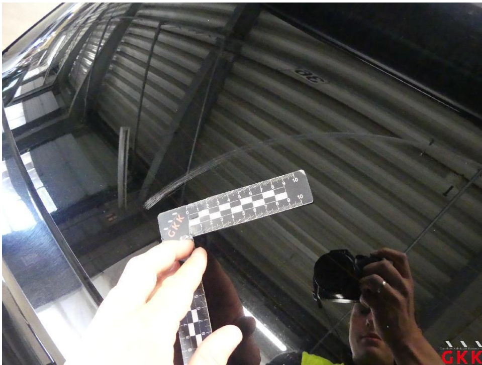
Bild 22 Heckscheibe, getönt, verkratzt, ersetzen
