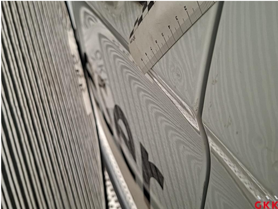
Bild 37 Schiebetür rechts, beschädigt, instand setzen - lackieren
