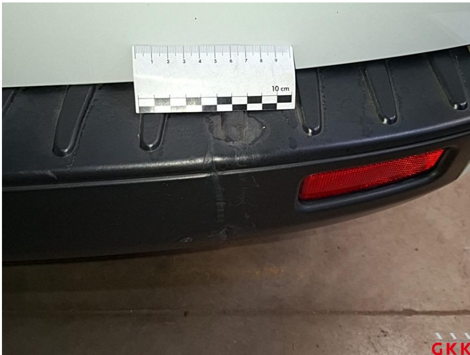
Bild 28 Stoßfänger hinten, Verkleidung -unlackiert-, beschädigt, ersetzen
