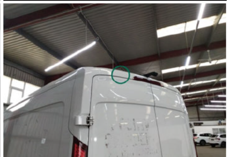
Dachholm / Hinten / Delle
