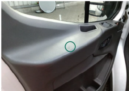
Türverkleidung / Vorne Links / Brandstelle
