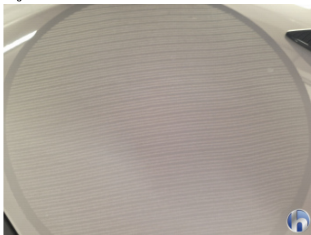
2. Dach Hagelschaden - Sanft Instandsetzen
