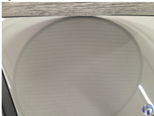
2. Dach Hagelschaden - Sanft Instandsetzen
