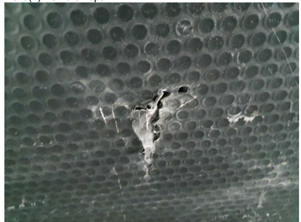
Beschädigung #4: Schiebetür rechts: Verkleidung - beschädigt - erneuern
