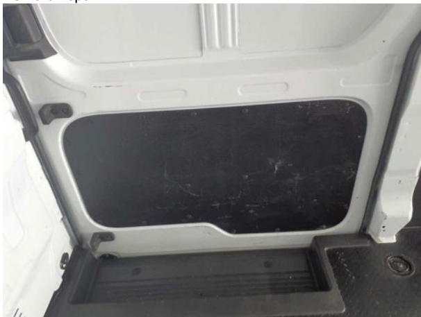
Beschädigung #4: Schiebetür rechts: Verkleidung - beschädigt - erneuern
