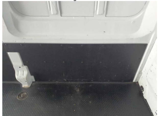
Beschädigung #7: Seitenwand links: Innenverkleidung - beschädigt - erneuern
