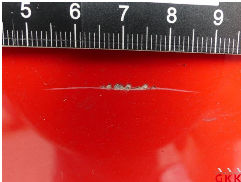
Bild 49. Seitenwand rechts, beschädigt, instand setzen - lackieren
