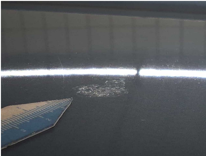
Damage 10: Roof: Roof (Verätzungen) - Paint defect - Paint
