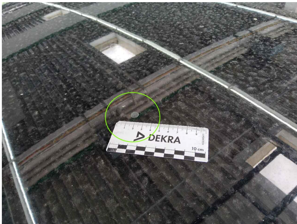
Bild 27 : Lackierung Dach Baumharzreste reinigen und
