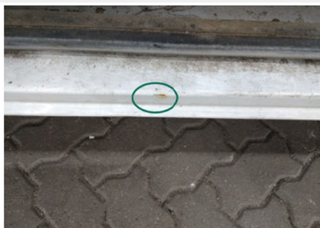
Türeinstieg / Rechts / Rost
