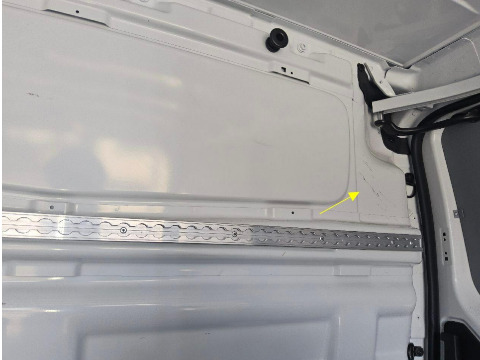
Bild 31 : Laderaum, diverse Kratzer
