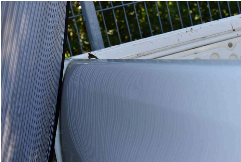
Bild 62 rechte Seite Seitenwand rechts Kratzer/Dellen
