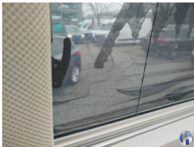
7. Sonnenschutz Gebrauchsspuren - Ohne Reparatur
