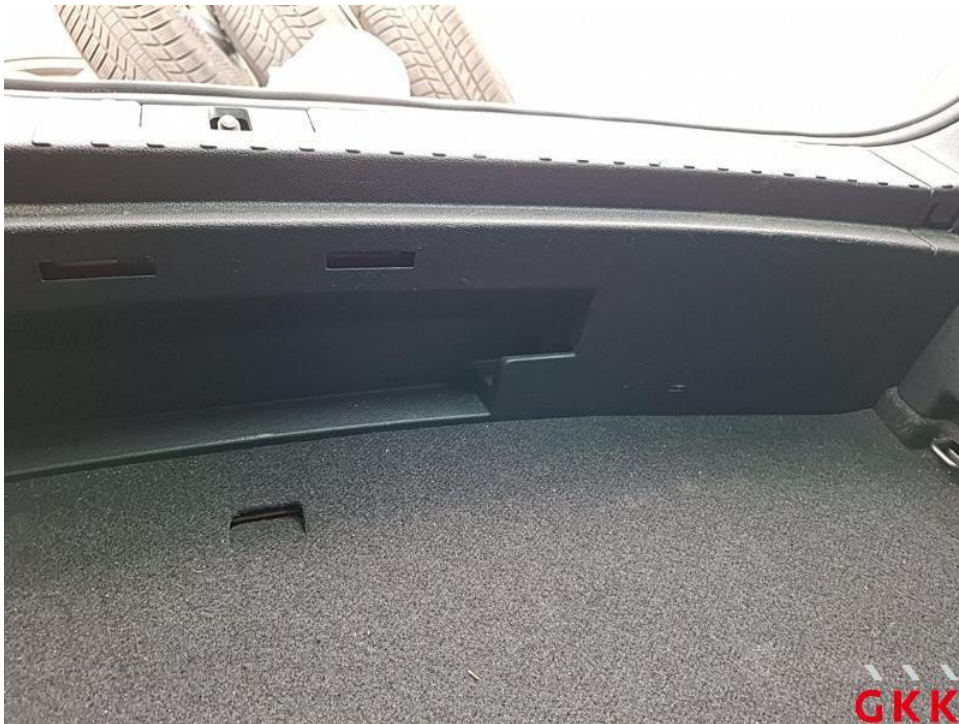
Bild 26. Ladekante, Abdeckung, verkratzt, ersetzen
