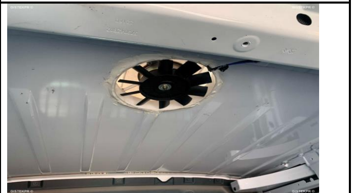
Foto daños internos 24
