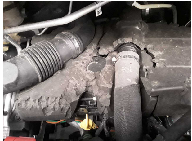
Beschädigung #4: Motor: Motorabdeckung - Marderschaden - erneuern
