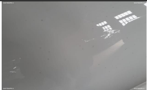
Foto daños externos 1
