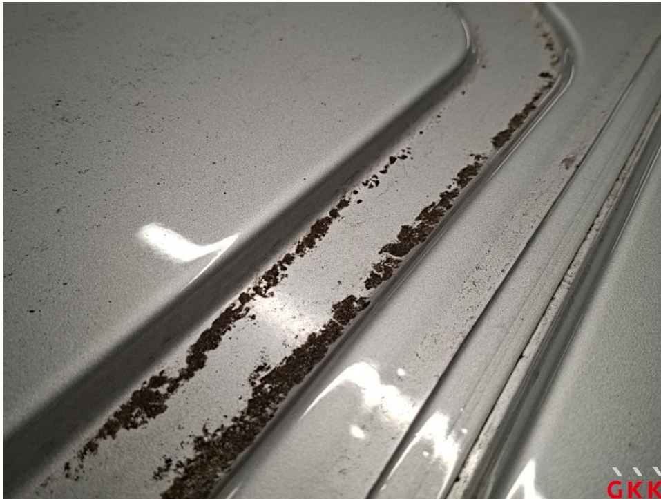
Bild 27 Dach, Harzanhaftungen/-rückstände, aufbereiten
