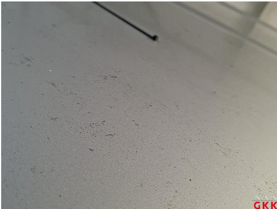
Bild 26 Dach, Harzanhaftungen/-rückstände, aufbereiten
