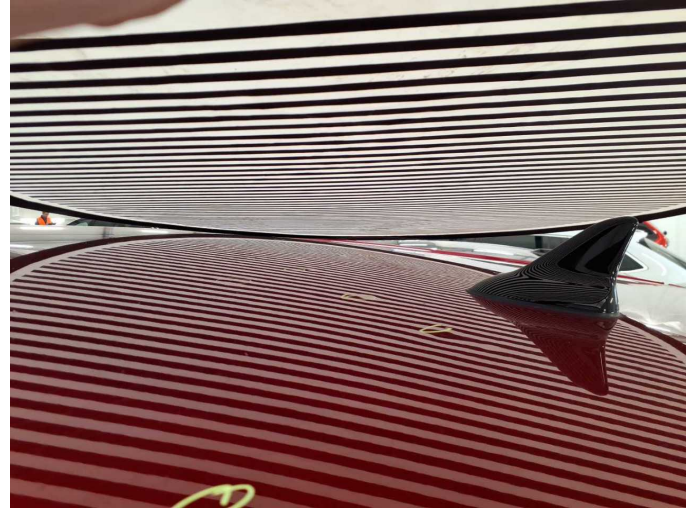
Damage 7: Roof: Roof (30 Dellen auf dem dach mit 2cm Durchmesser) - Damage by hail - Repair
