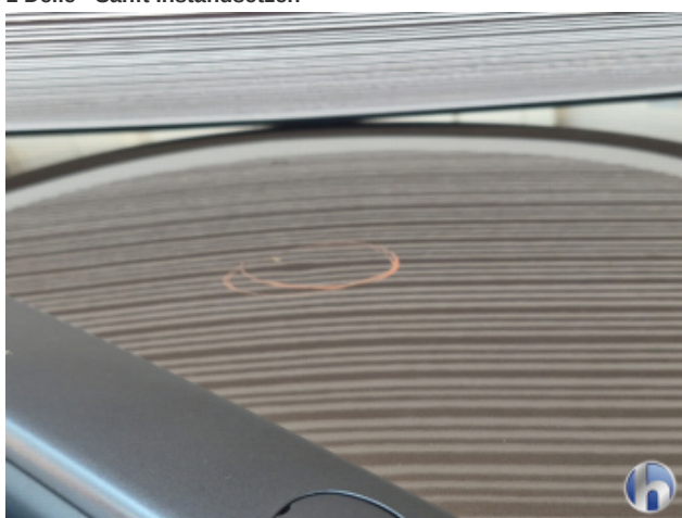
3. Dach 1 Delle - Sanft Instandsetzen
