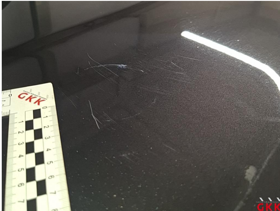
Bild 48 Dach, verkratzt, lackieren
