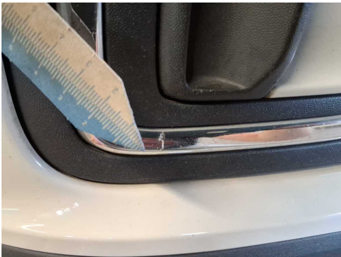
Damage 3: Front bumper: Air-inlet grille (links, rechts, + Kunststoffeinsatz) - Broken / torn - Replace
