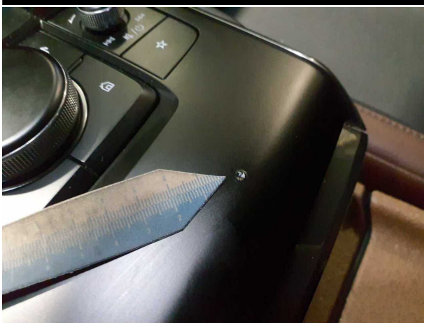
Beschädigung #3: Verkleidungen/Abdeckungen: Zierleiste / Dekorleiste - beschädigt - erneuern
