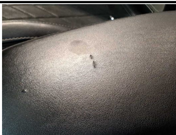
Beschädigung #9: Sitz vorn: Armlehnen - beschädigt - erneuern
