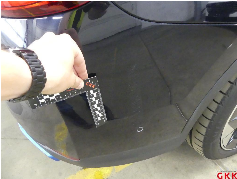
Bild 29 Stoßfänger hinten, Verkleidung -lackiert-, beschädigt, ersetzen
