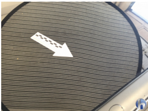
2. Dach Gebrauchsspuren - Ohne Reparatur
