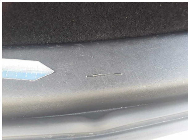
Beschädigung #1: Verkleidungen/Abdeckungen: Verkleidung Ladekante - beschädigt - erneuern
