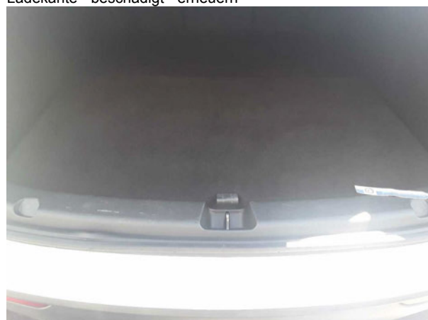
Beschädigung #1: Verkleidungen/Abdeckungen: Verkleidung Ladekante - beschädigt - erneuern
