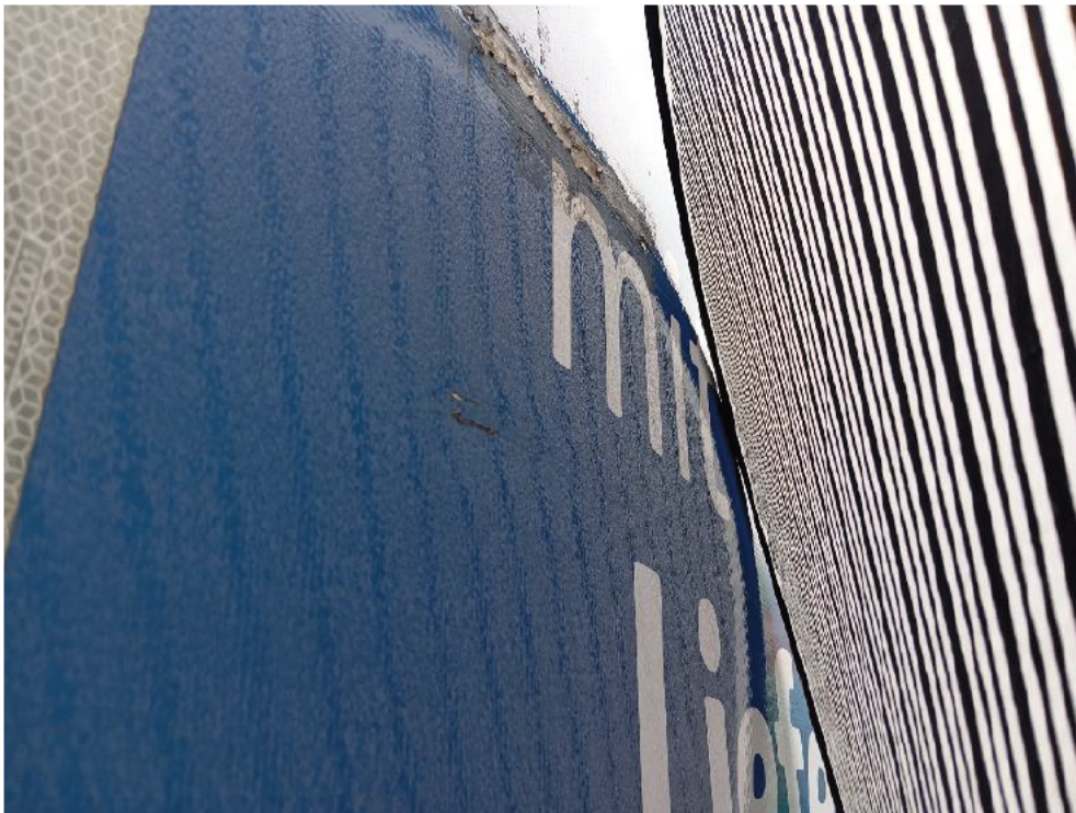
Bild: 39 Seitenwand Kühlkofferaufbau rechts deformiert
