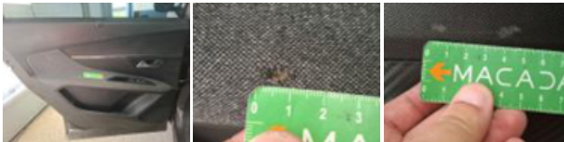
Ciel de toit, Déchirure, E - Remplacer
