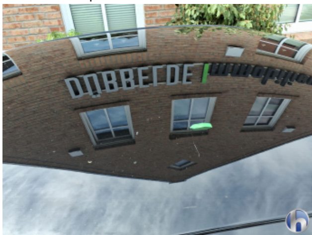
15. Dach Kratzer - Lackieren
