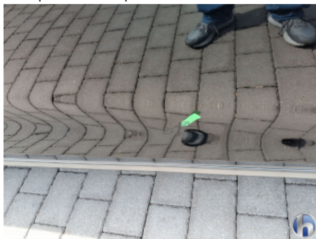
10. Tür Vorne - Rechts Verdellt - Sanft Instandsetzen
