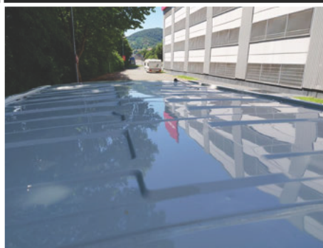
Dach / - / Hagelschaden
