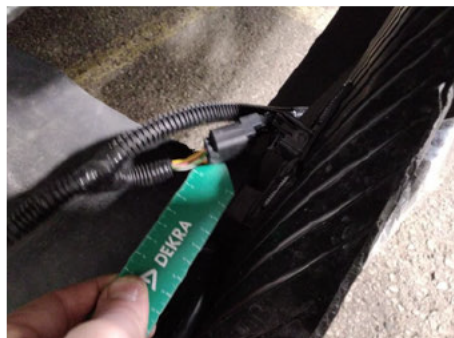
Sensor Einparkhilfe / Hinten / Defekt
