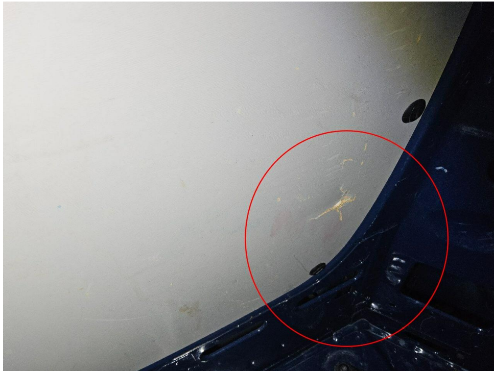
Bild 13 : Verkleidung Schiebetür beschädigt
