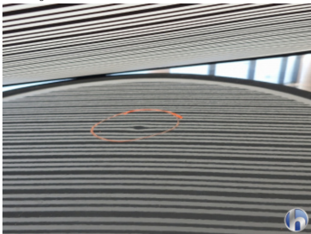
1. Dach Gebrauchsspuren - Ohne Reparatur
