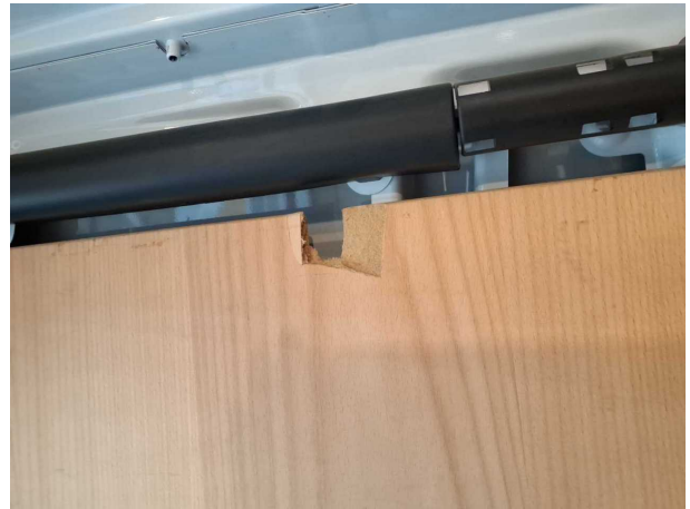
Beschädigung #2: Seitenwand links: Innenverkleidung - beschädigt - erneuern
