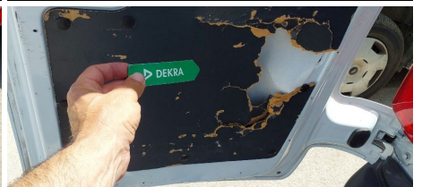
Guarnecido de puerta / Trasero / Roto
