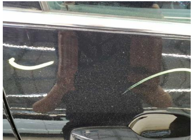
Beschädigung #17: Tür vorn rechts: Tür - Kratzer - lackieren
