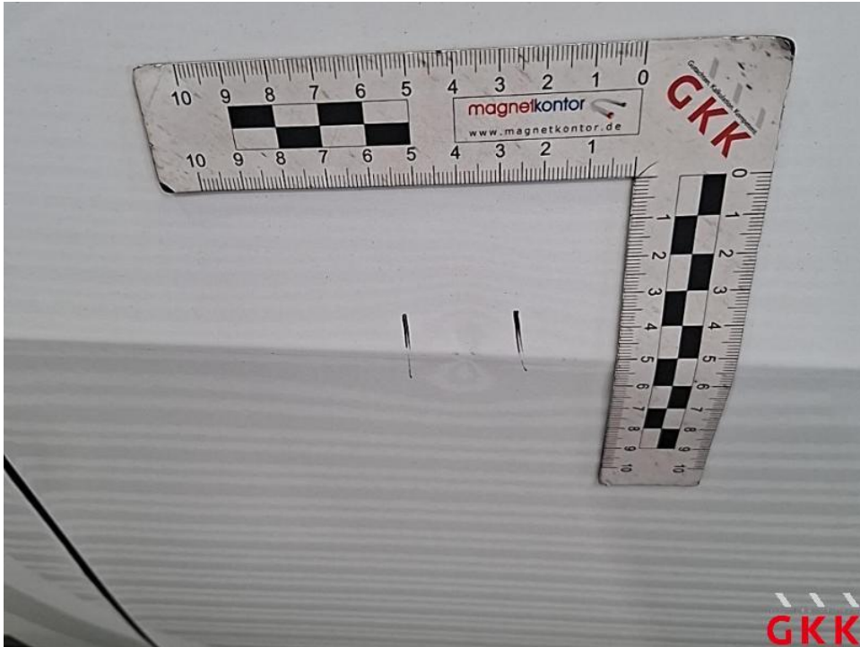
Bild 81. Tür vorne rechts, beschädigt, instand setzen - lackieren
