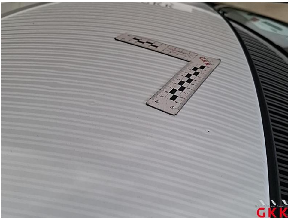
Bild 46. Dach, Hagelschaden, kalt drücken
