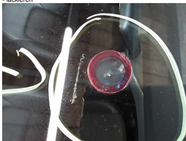
Beschädigung #17: Verglasung: Frontscheibe (Rissbildung) - Steinschlag - erneuern
