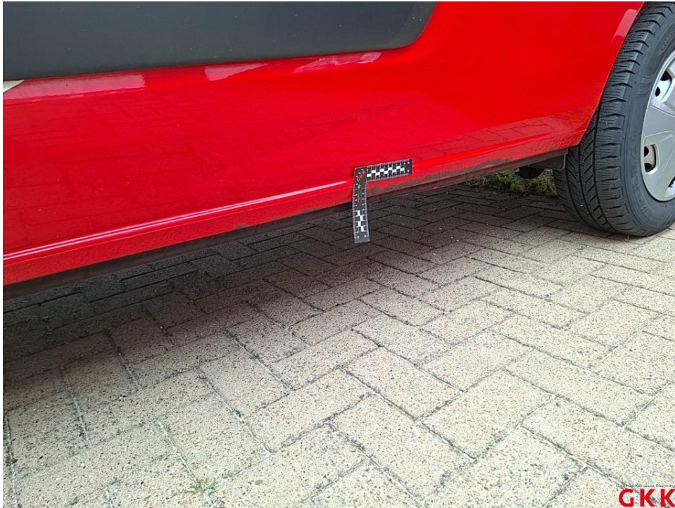
Bild 25. Schweller links, beschädigt, instand setzen - lackieren
