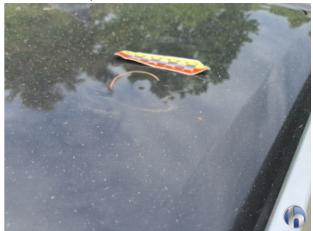
6. Dach Gebrauchsspuren - Ohne Reparatur
