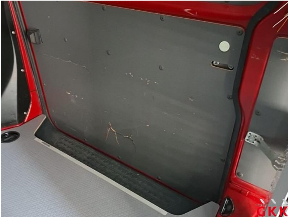
Bild 53. Schiebetür rechts, Innenverkleidung, beschädigt, ersetzen
