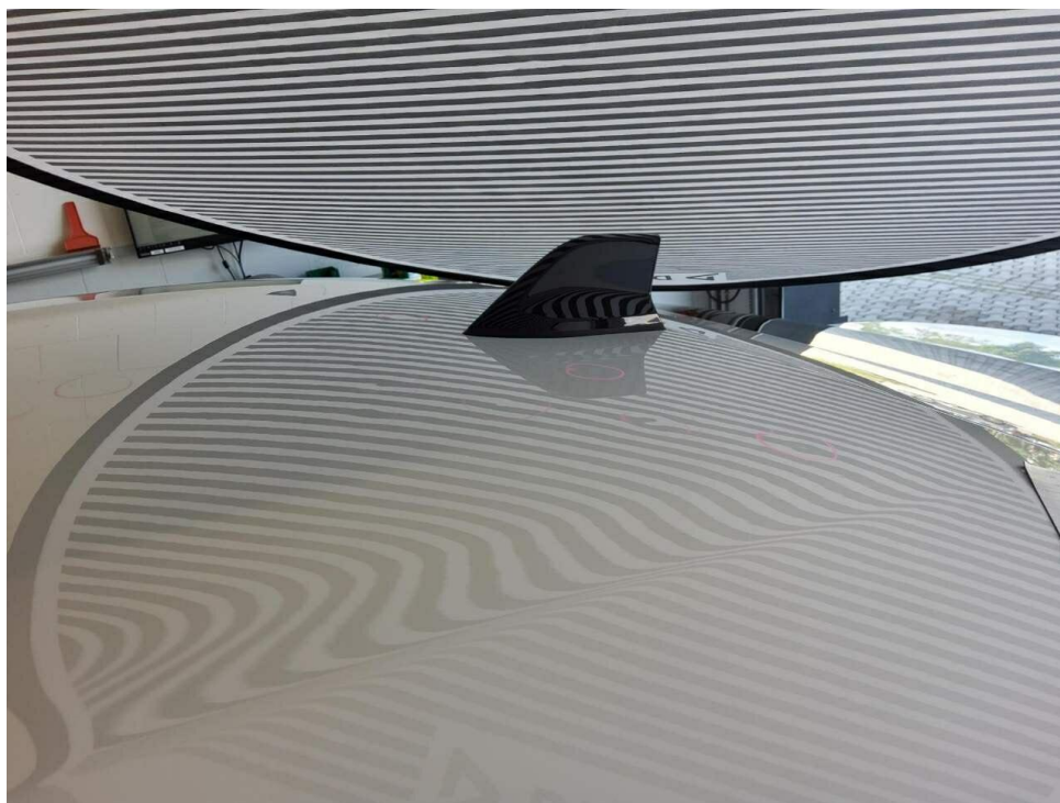
Bild 20 : Dach, mehrfach eingedellt, drücken 50 Dellen
