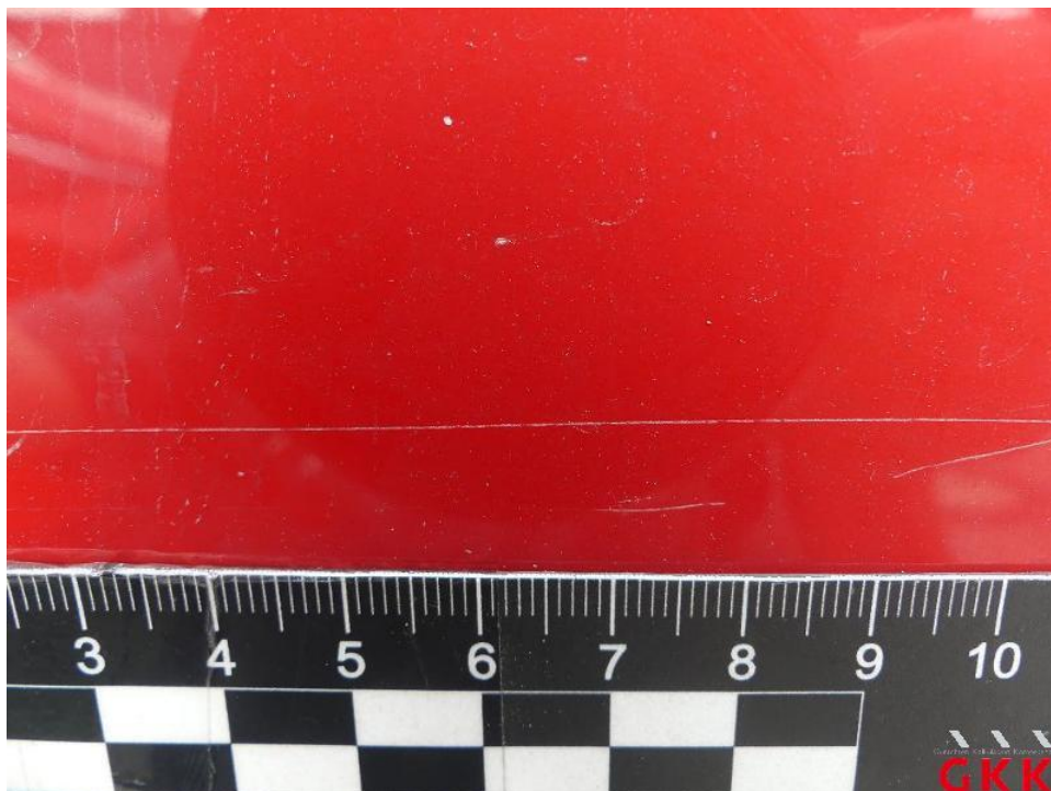
Bild 53. Schiebetür rechts, verkratzt, lackieren
